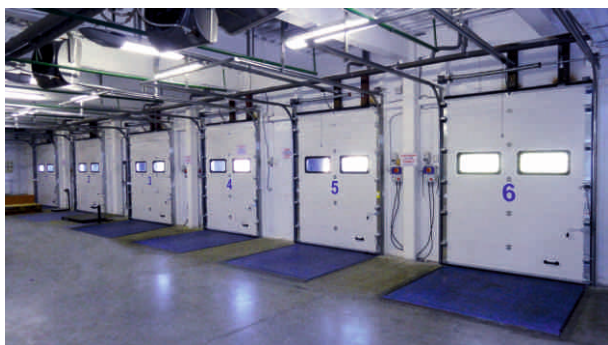
Линия Гринн, ИООО, г. Гомель - герметизатор проема - уравнительная платформа - секционные ворота
