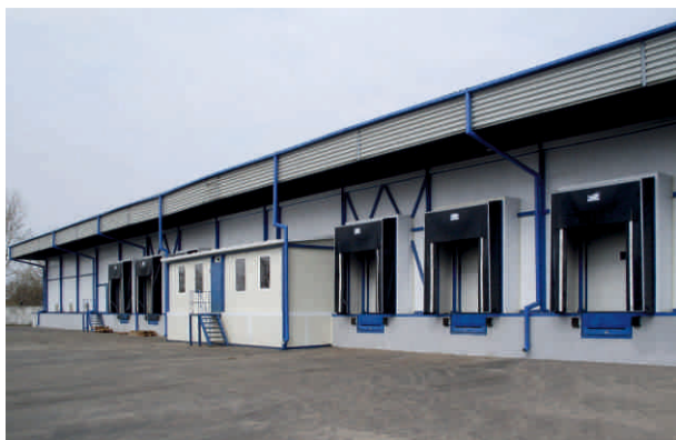
Санта Бремор, СП ООО, г. Брест - герметизатор проема - уравнительная платформа - секционные ворота
